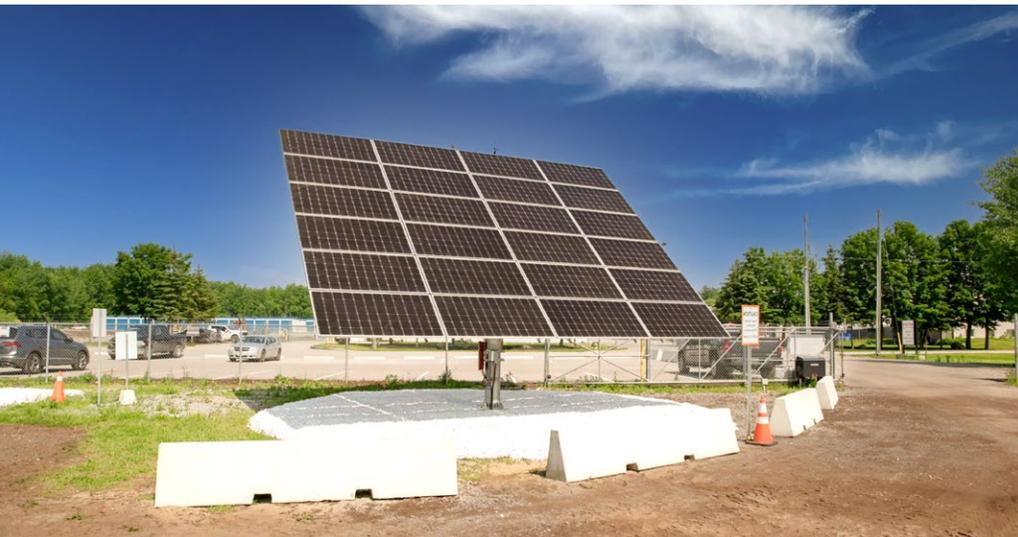
Le système de suivi solaire installé au Centre de formation et d'innovation d'Aecon à Holland Landing, en Ontario
